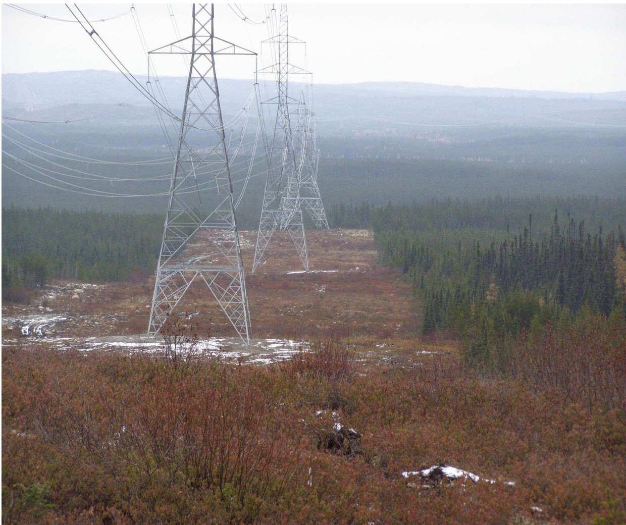
Ligne électrique au site Rose lithium-tantale
