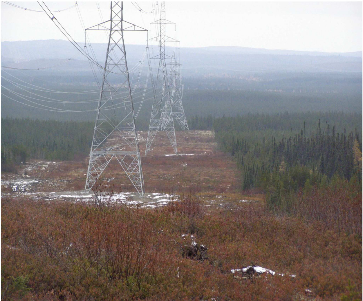
Ligne électrique au site Rose lithium-tantale
