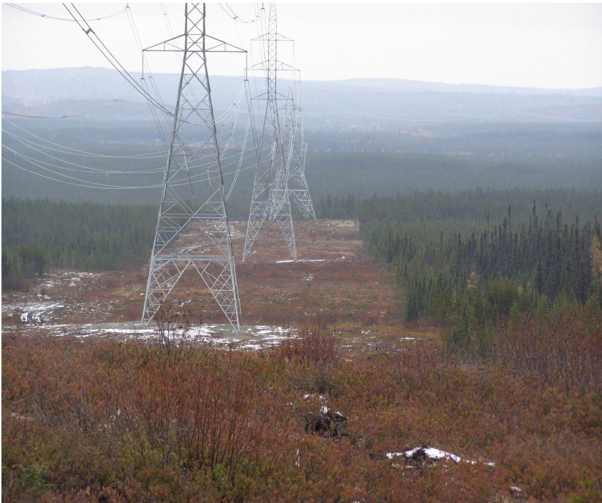
Ligne électrique au site Rose lithium-tantale
