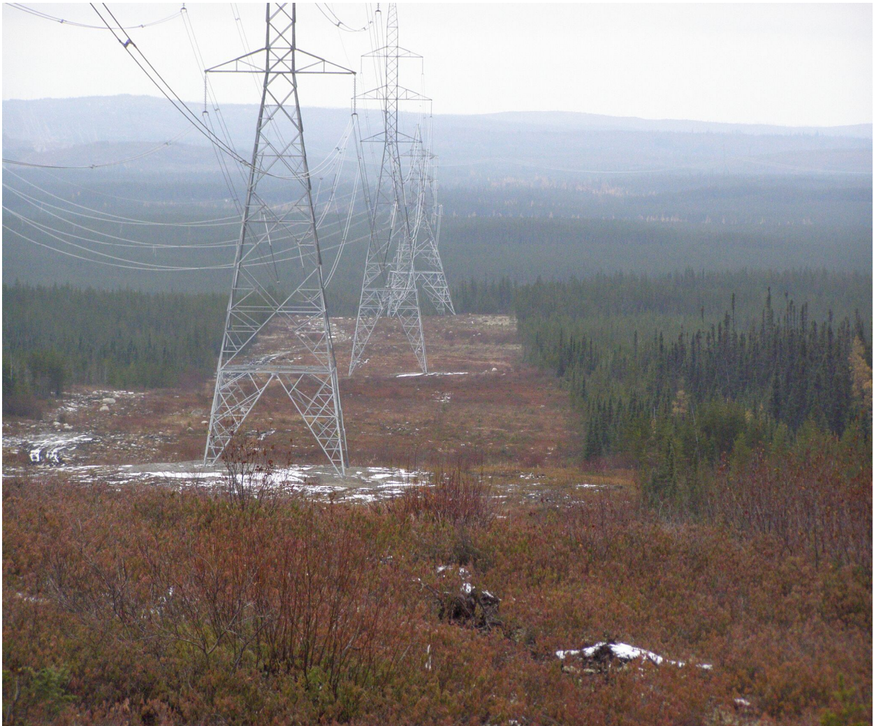
Ligne électrique au site Rose lithium-tantale
