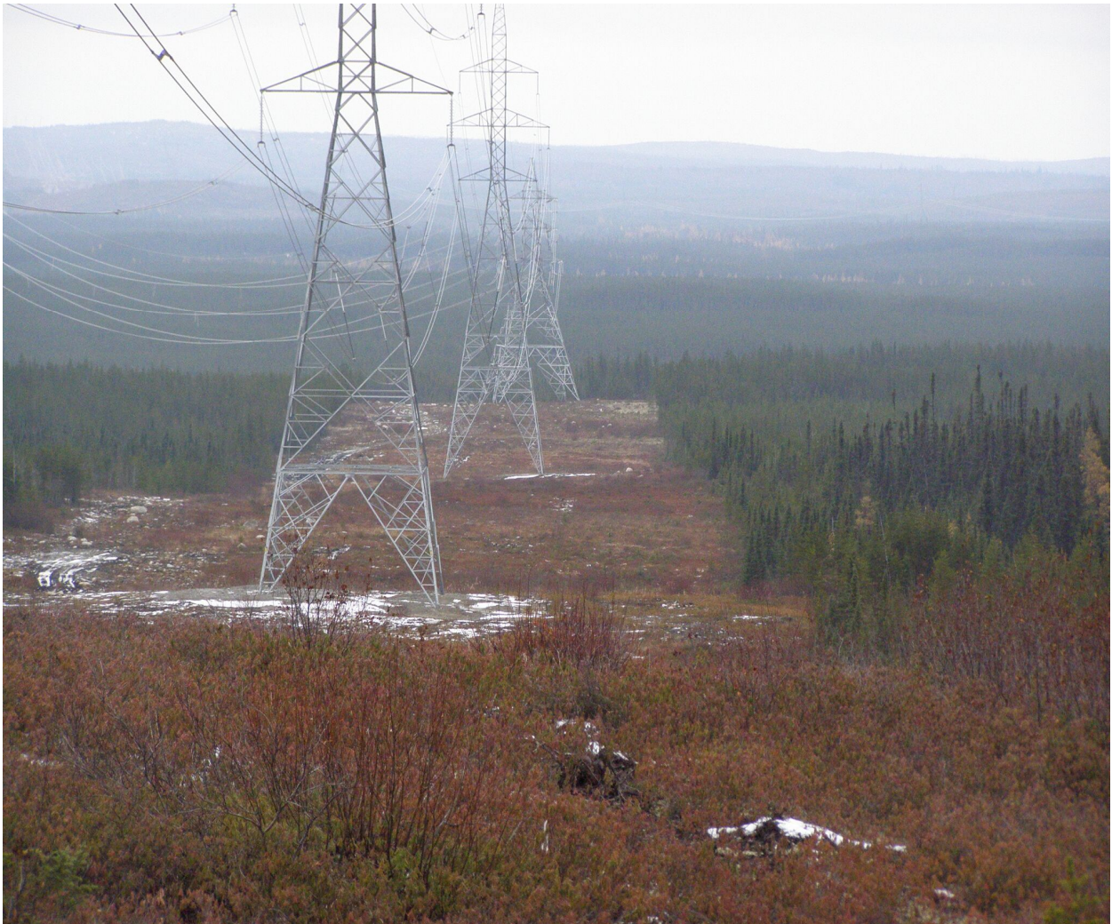
Ligne électrique au site Rose lithium-tantale
