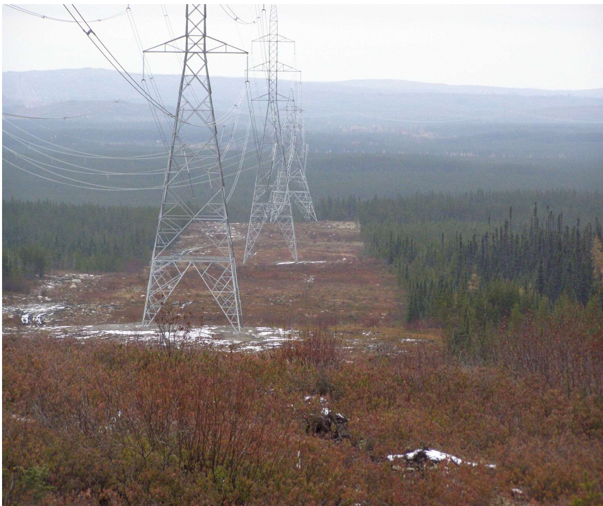
Ligne électrique au site Rose lithium-tantale
