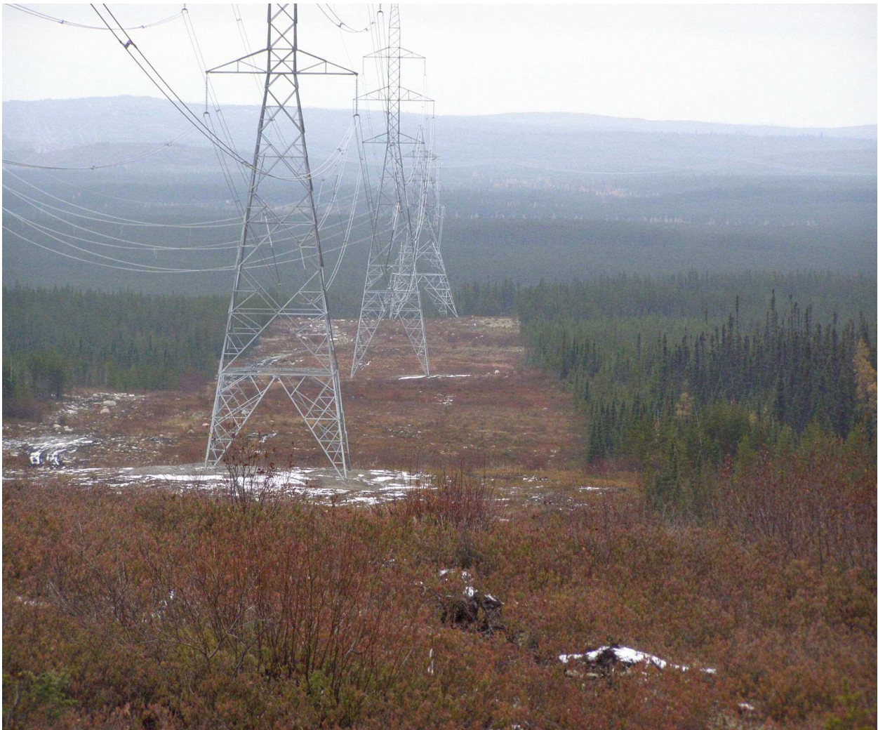
Ligne électrique au site Rose lithium-tantale
