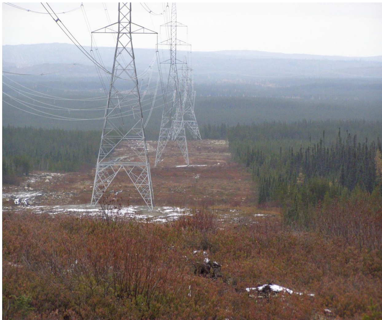
Figure 6 – Ligne électrique au site Rose
