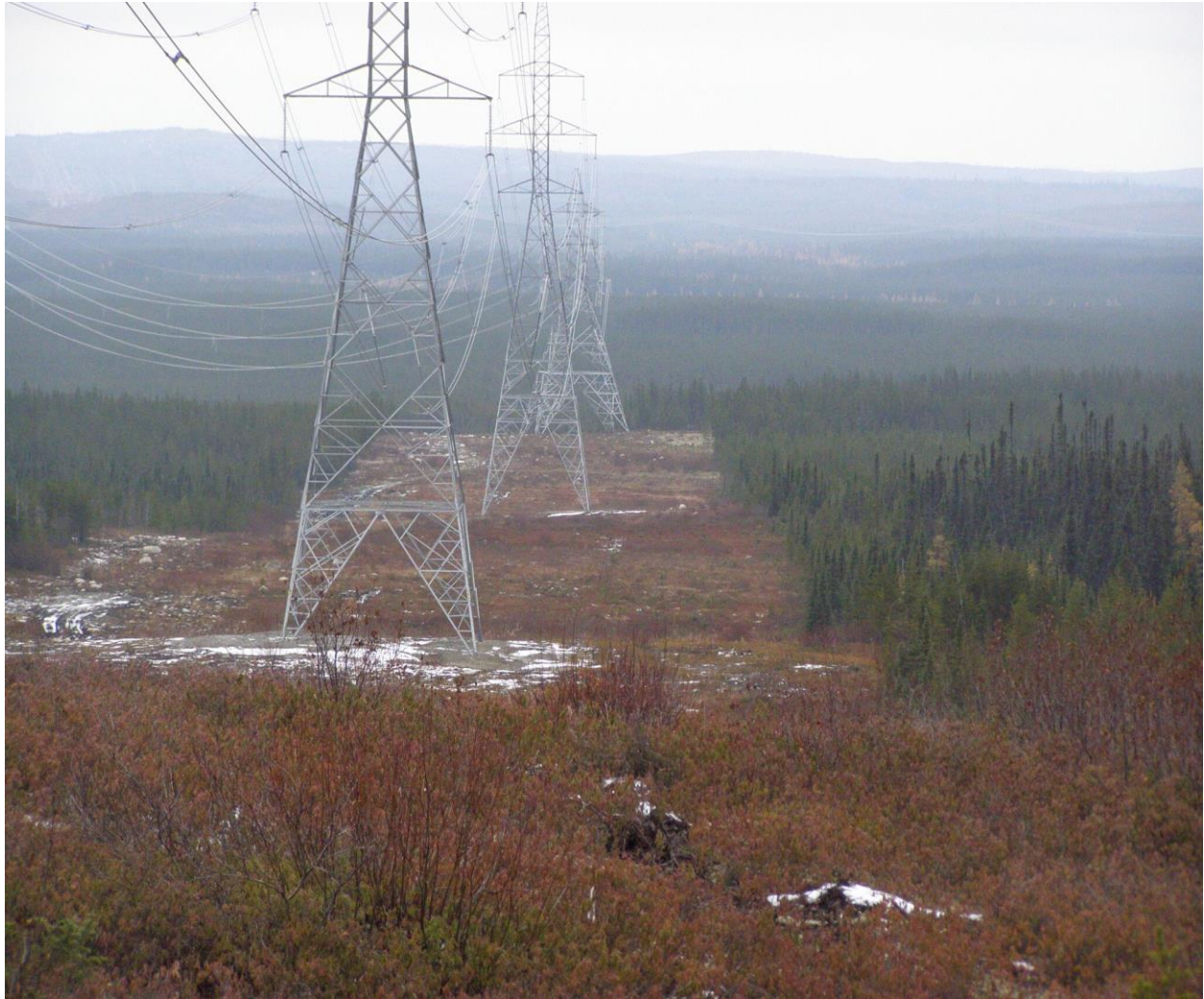
Figure 6 – Ligne électrique au site Rose
