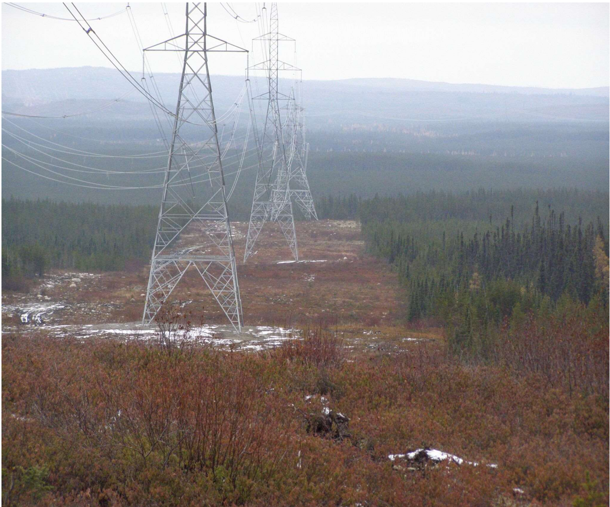
Ligne électrique au site Rose lithium-tantale
